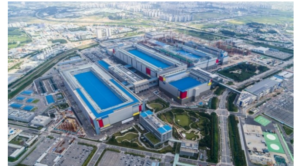
삼성 평택캠퍼스 반도체 공장
